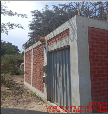
Pozo a tierra
