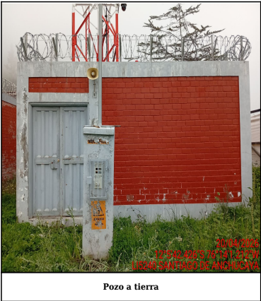
Pozo a tierra
