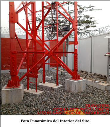
Foto Panorámica del Interior del Site
