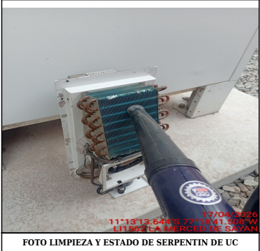
FOTO LIMPIEZA Y ESTADO DE SERPENTIN DE UC
