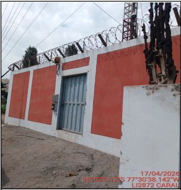
Pozo a tierra
