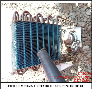
FOTO LIMPIEZA Y ESTADO DE SERPENTIN DE UC
