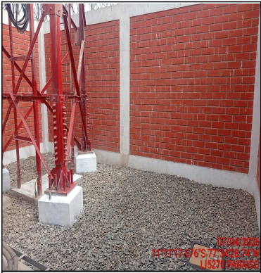
Foto Panorámica del Interior del Site
