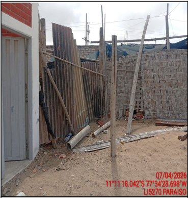
Pozo a tierra
