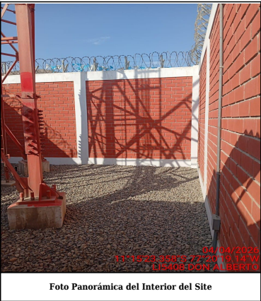
Foto Panorámica del Interior del Site
