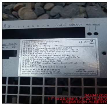
FOTO DE PLACA DE UNIDAD EVAPORADORA
