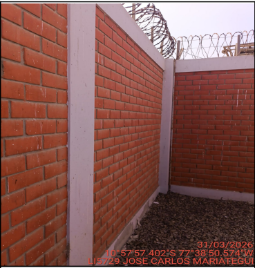
Foto Panorámica del Interior del Site
