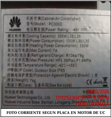
FOTO CORRIENTE SEGUN PLACA EN MOTOR DE UC
