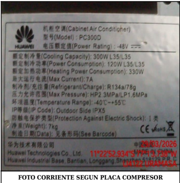
FOTO CORRIENTE SEGUN PLACA COMPRESOR
