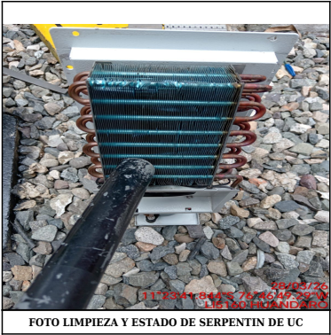
FOTO LIMPIEZA Y ESTADO DE SERPENTIN DE UC
