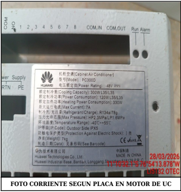
FOTO CORRIENTE SEGUN PLACA EN MOTOR DE UC
