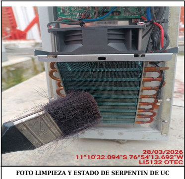
FOTO LIMPIEZA Y ESTADO DE SERPENTIN DE UC
