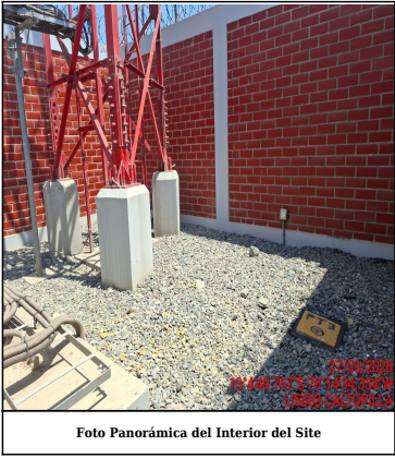
Foto Panorámica del Interior del Site
