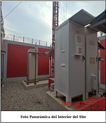
Foto Panorámica del Interior del Site
