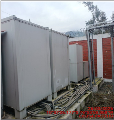
Foto Panorámica del Interior del Site
