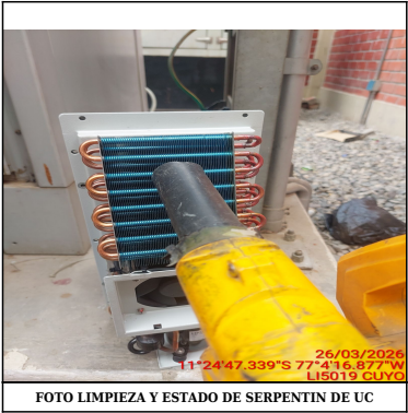
FOTO LIMPIEZA Y ESTADO DE SERPENTIN DE UC
