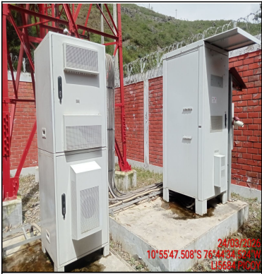
Foto Panorámica del Interior del Site
