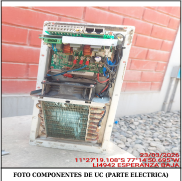
FOTO COMPONENTES DE UC (PARTE ELECTRICA)
