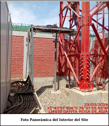
Foto Panorámica del Interior del Site
