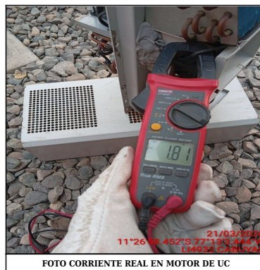
FOTO CORRIENTE REAL EN MOTOR DE UC
