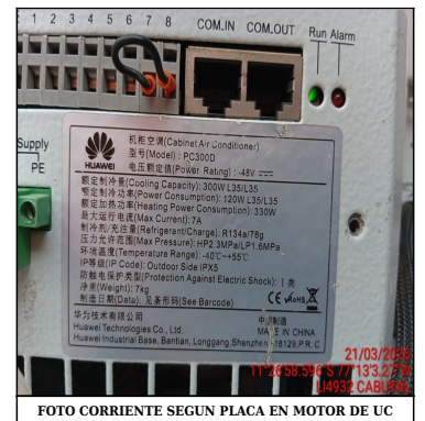
FOTO CORRIENTE SEGUN PLACA EN MOTOR DE UC
