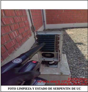
FOTO LIMPIEZA Y ESTADO DE SERPENTIN DE UC
