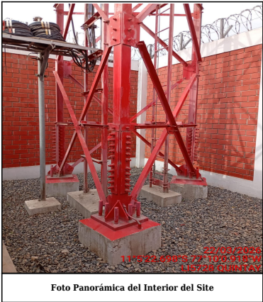
Foto Panorámica del Interior del Site
