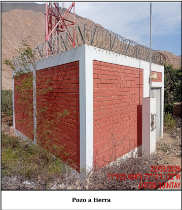
Pozo a tierra
